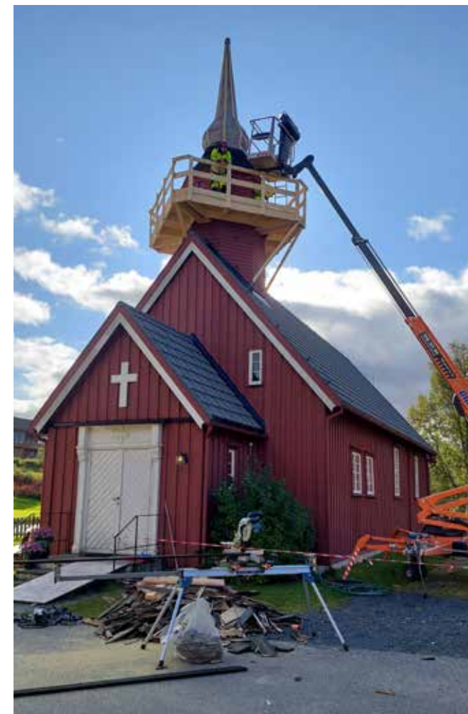
Arbeidet med spiret i full gang.
